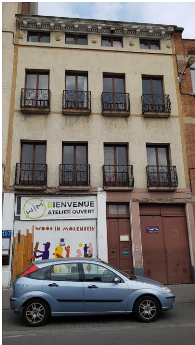
Façade bâtiment rue Heyvaert 107-109
