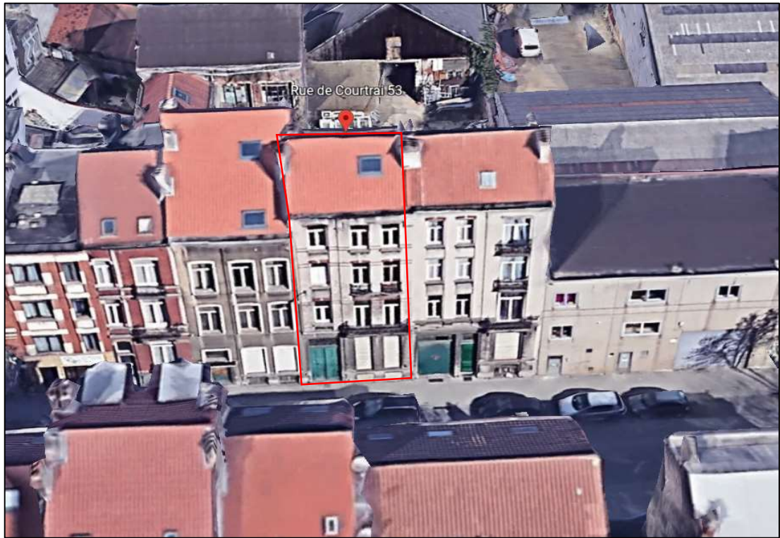
(Google Earth façade avant)
