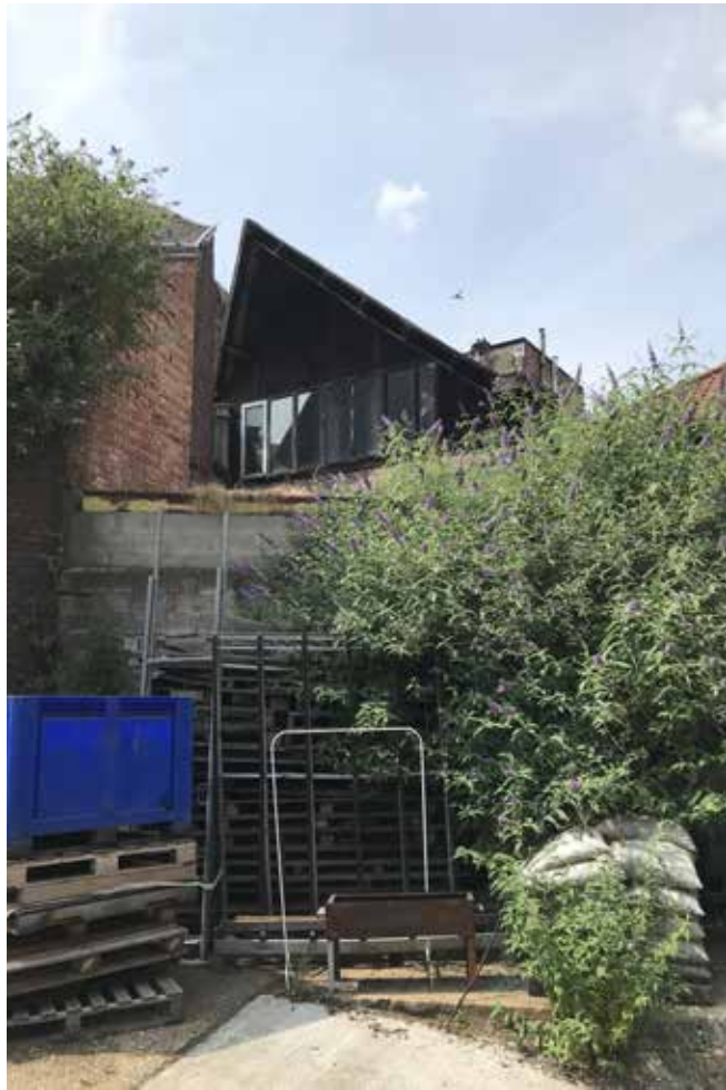
Photos du atelier de la rue d'Ostende 92. Foto's van het atelier aan de Oostendestraat 92.
