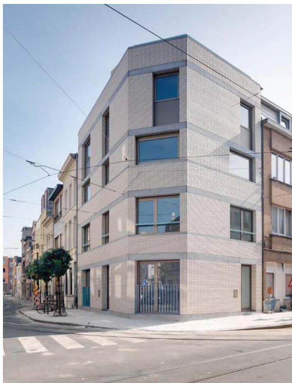
source / bron: https://www.agvespa.be/projecten/spoorstraat-2-rotterdamstraat-87
