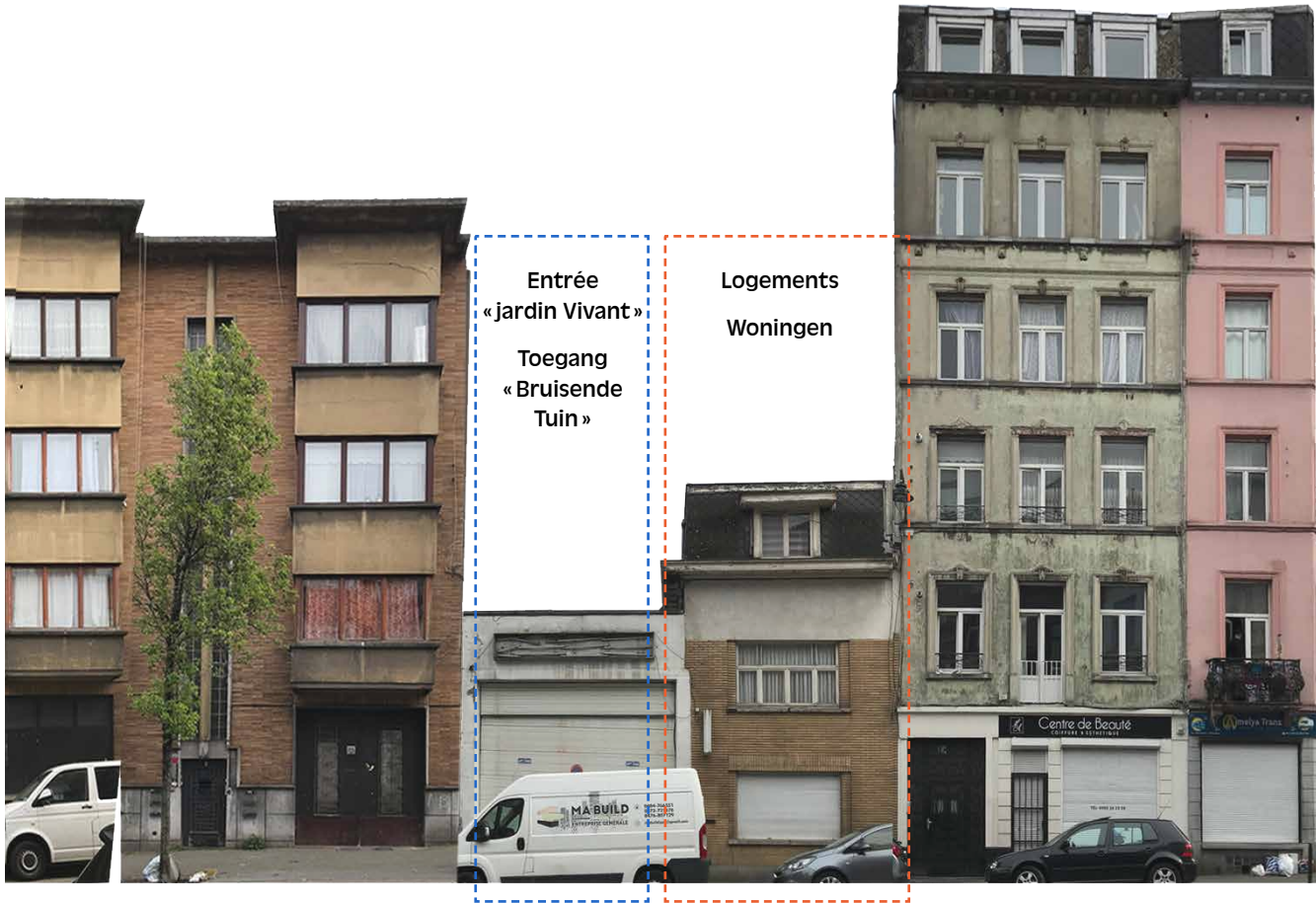
Rue d'Ostende 92 Oostendestraat 92
