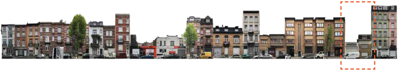
Rue d'Ostende 92 Oostendestraat 92
