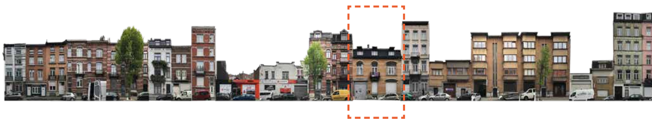
Rue d'Ostende 74 Oostendestraat 74
