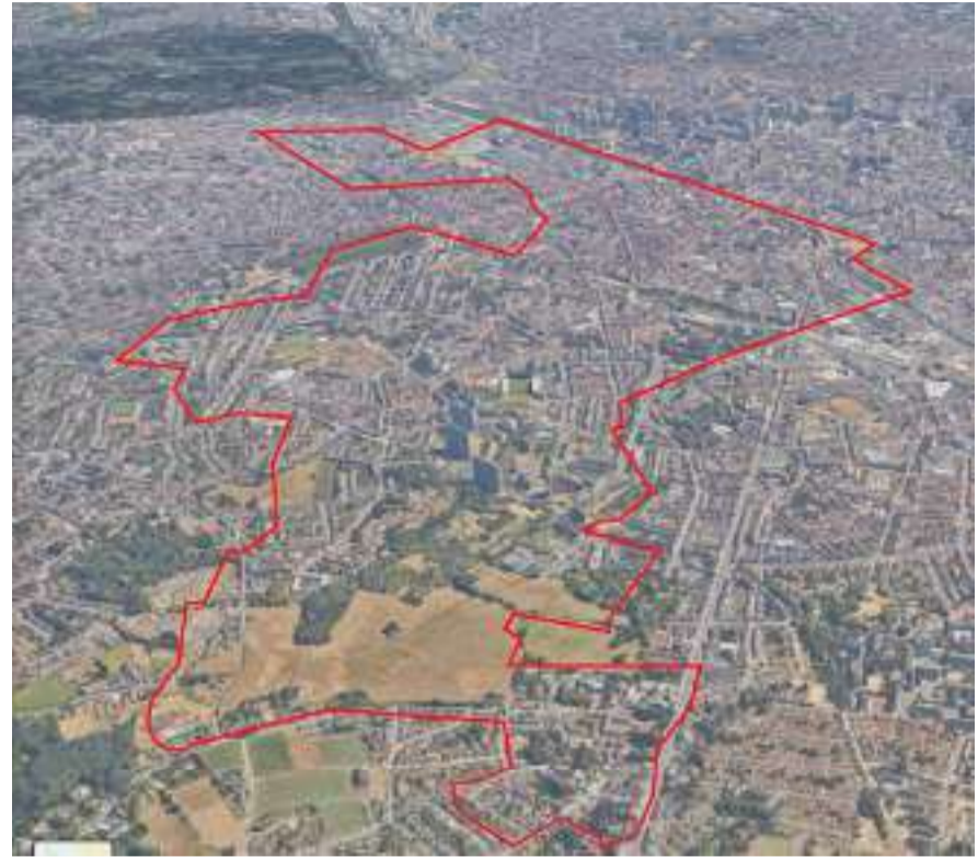
Localisation de la commune. Vue aérienne de la Scheutbos.
