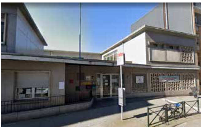
2- Entrée de l'école «la Rose des Vents» Ingang e naar «la Rose des Vents» school
