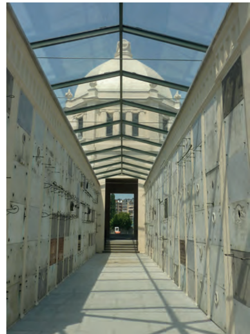
La galerie funéraire du cimetière communal, construite à partir de 1880 | De graf galerij van de gemeentelijke begraafplaats, gebouwd vanaf 1880, Photo/foto MoMuse, 2016 (sans cote)
