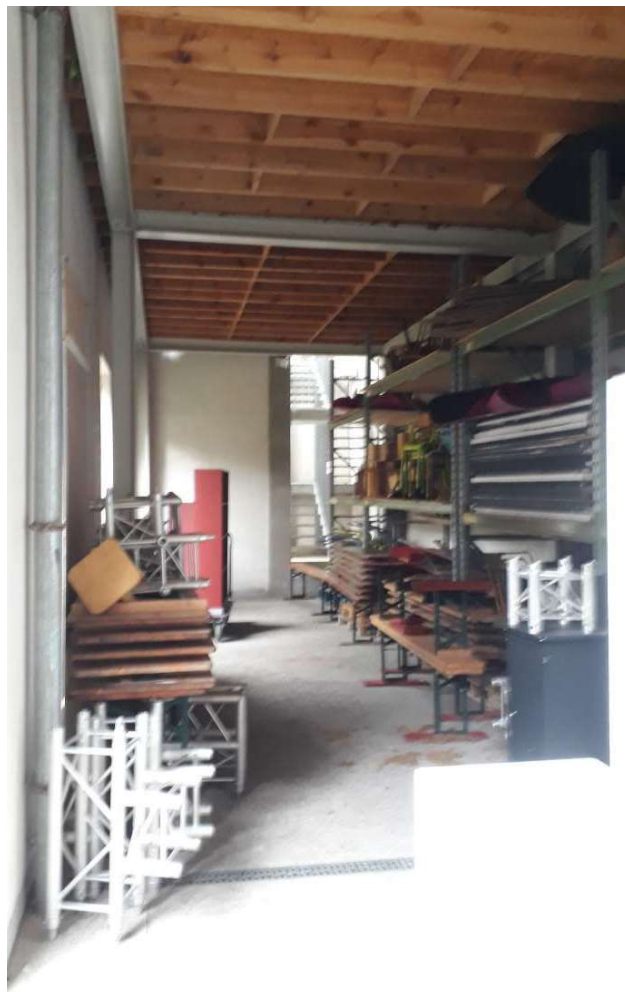
STRUCTURE OUVERTE (MAINTENANT STOCKAGE) - OPEN STRUCTUUR (NU OPSLAG)
