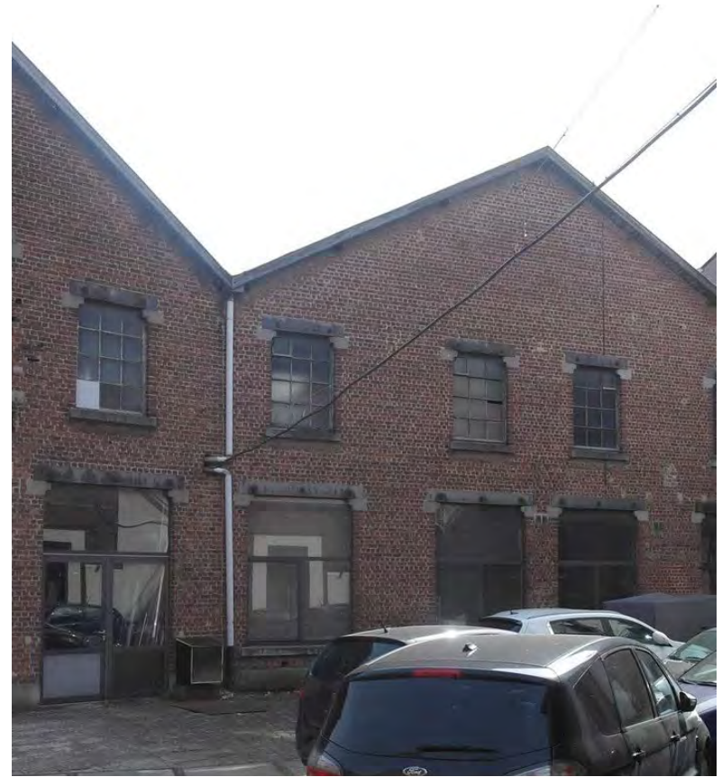
SA L'OXHYDRIQUE INTERNATIONALE, PIERRE VAN HUMBEEKSTRAAT 31 - 33: USINE / FABRIEK ARCHITECT: NOURBEAUX °1900 - 1910
