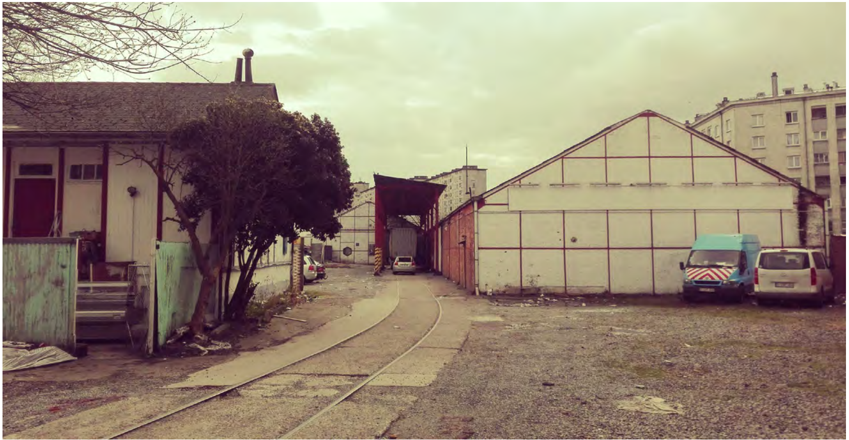
HALLE DE DELHAIZE À HAUTEUR DE BEEKKANT DELHAIZE HAL T.H.V. BEEKKANT
