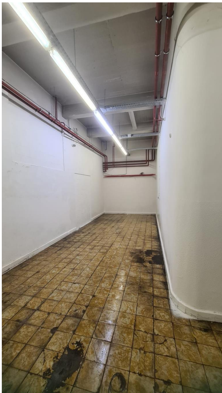
Salle de stockage au RDC
