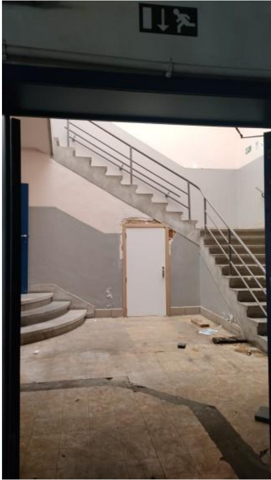
Trappenhuis van de begane grond naar de bovenverdiepingen.
