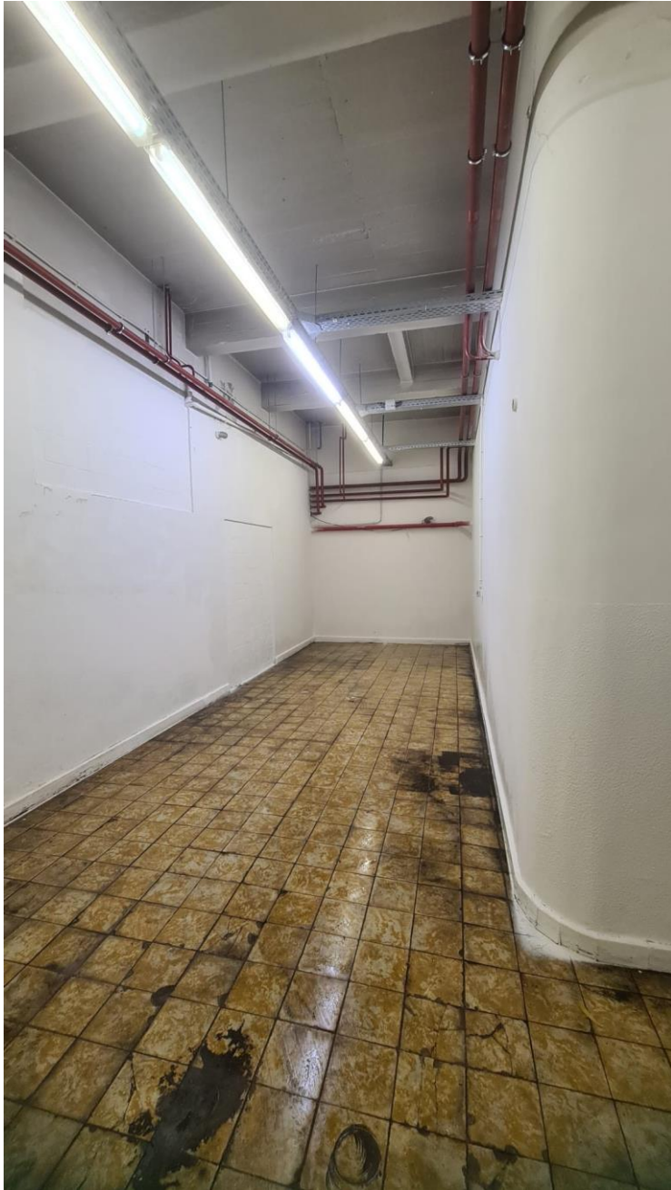
Opslagruimte op begane grond
