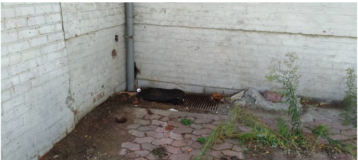
Coin des anciens événements (tuyaux encore visibles dans un coin de la cave) Hoek van de oude verluchttingsbuizen (buizen nog zichtbaar in een hoek van de kelder)
